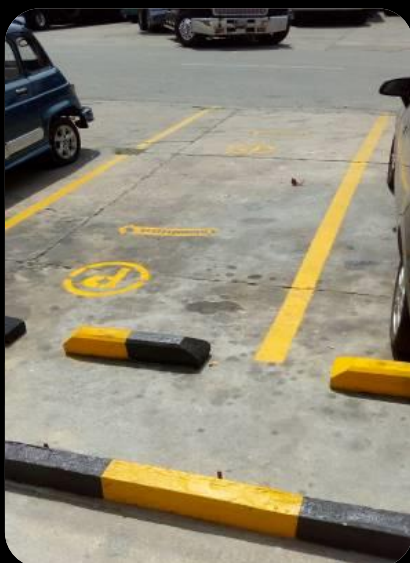
Pintura y Señalización de áreas
