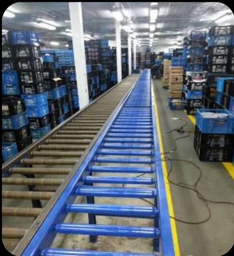
Fabricación y mantenimiento rieles de transporte
