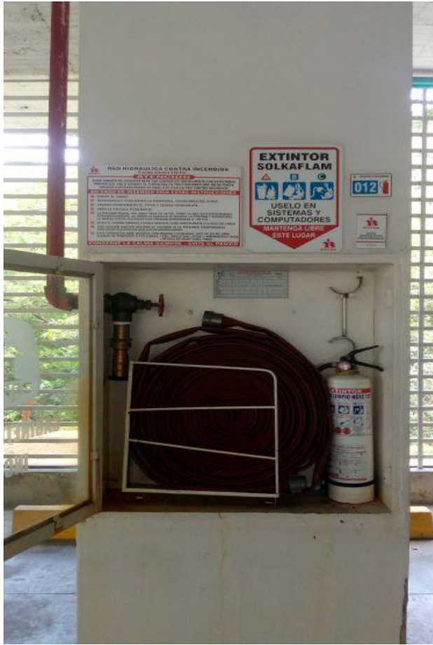
ANTES. Válvula con fuga se tiene tobera Instalada para contenerla
