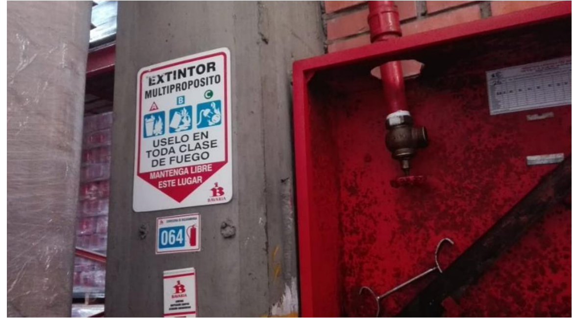
DESPUES. Se instala Válvula en Buen estado
