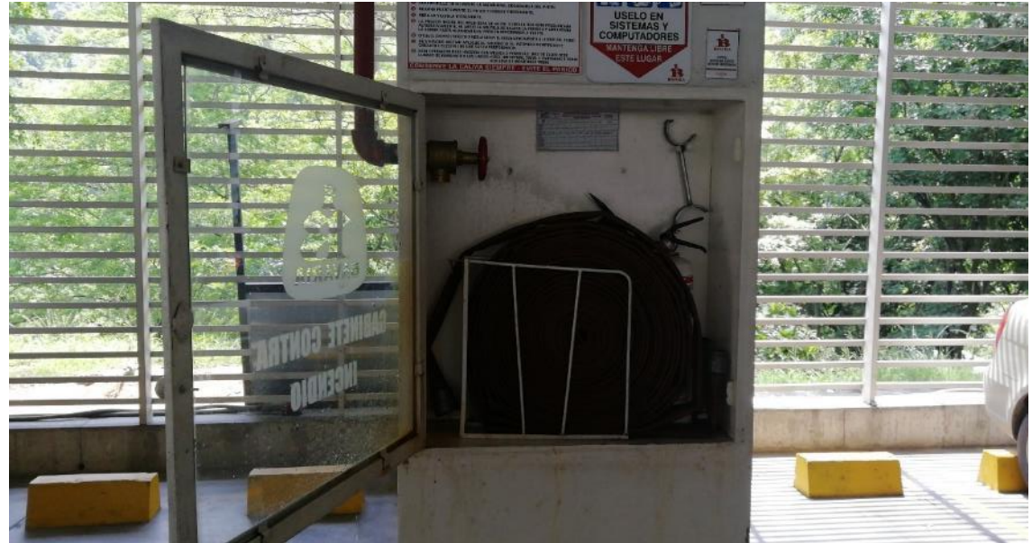
DESPUES. Se instala Válvula Nueva
