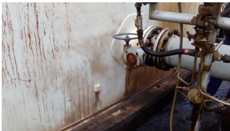
Foto No. 2. Válvula a Reparar Base Tanque
