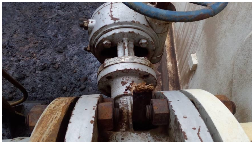
Foto No. 6 Calajan de Madera No. 2 Inestable, se toca y se mueve, No presenta fuga.
