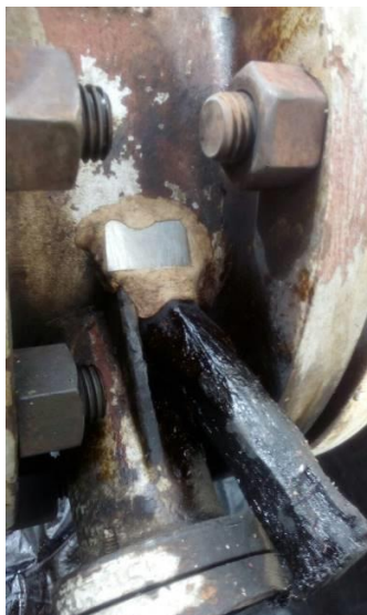
Foto No. 10 Contención Parcial Fuga en Vivo 3415
