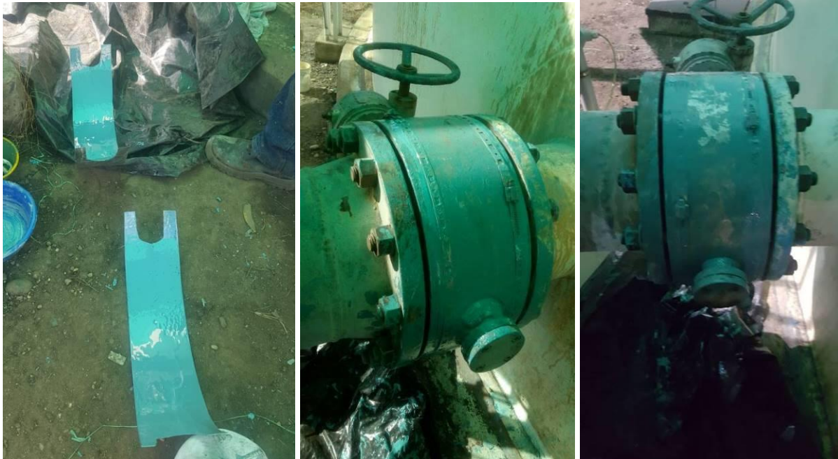
Foto No. 20 Media Lunas y abrazaderas instaladas
