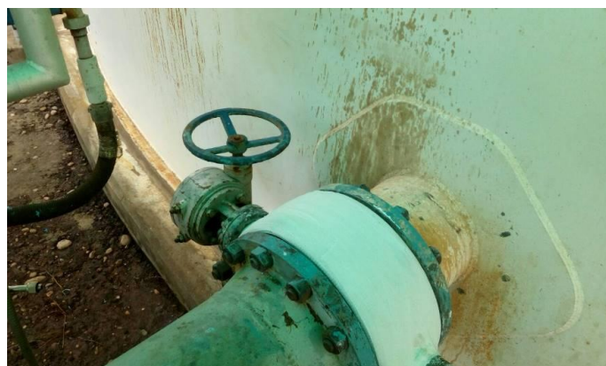
Foto No. 22 Instalación Wrap Seal
