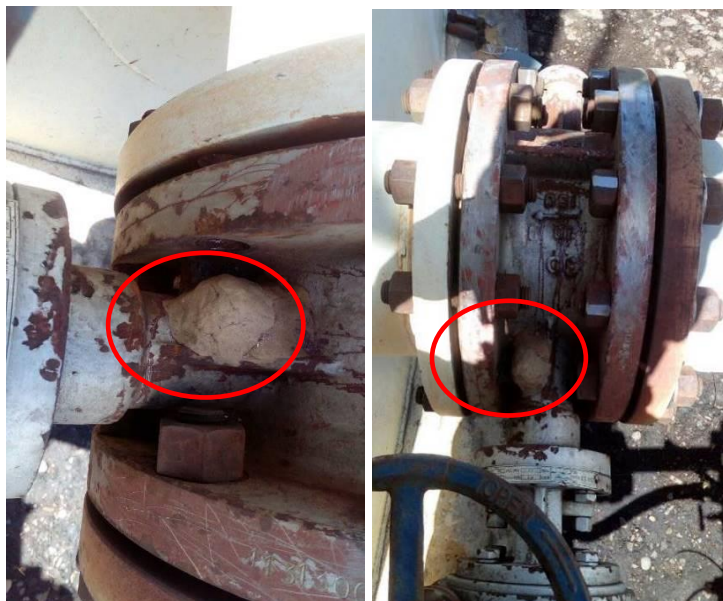
Foto No. 15 Calaján totalmente hermético con el uso SS106 de SealXpert V-3416
