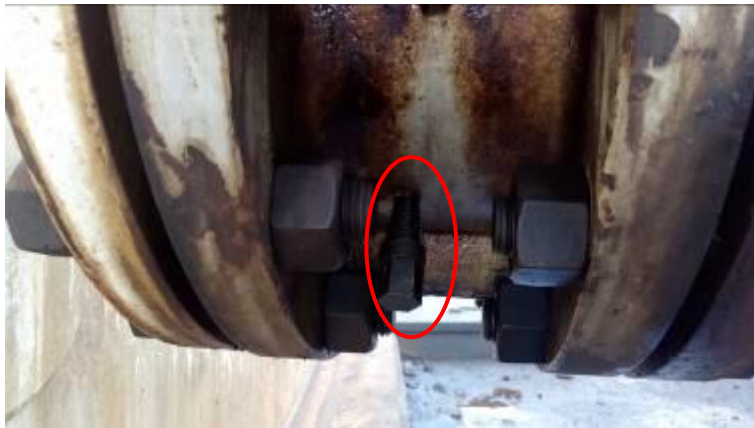
Foto No. 5 Calajan metálico, Estable no se mueve, no presenta fuga
