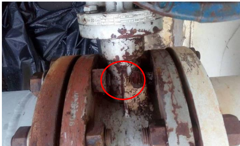
Foto No. 11 Calaján cortado Válvula 3416
