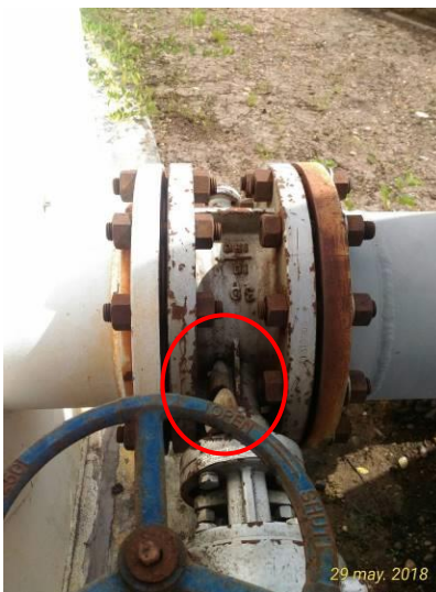
Foto No. 8 Válvula Tanque 3416, Presenta 1 sólo Calaján de madera apoyado en una piedra. Calaján Inestable, se mueve al tocarse con la mano. No presenta fuga
