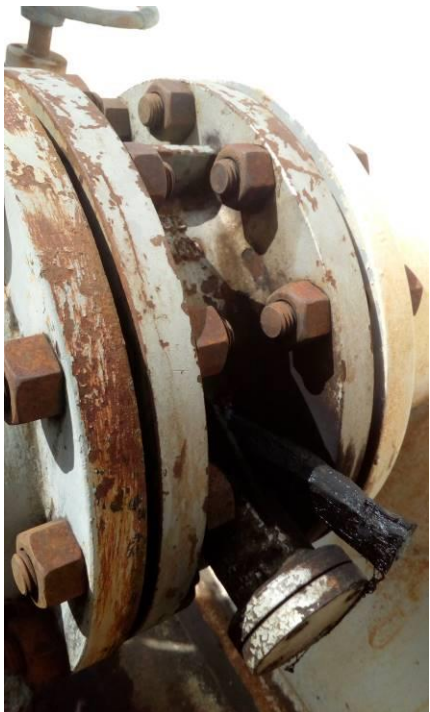
Foto No. 7 Calaján de Madera No. 2 Válvula 3415, Fuga en vivo de agua-crudo, Calaján muy inestable.
