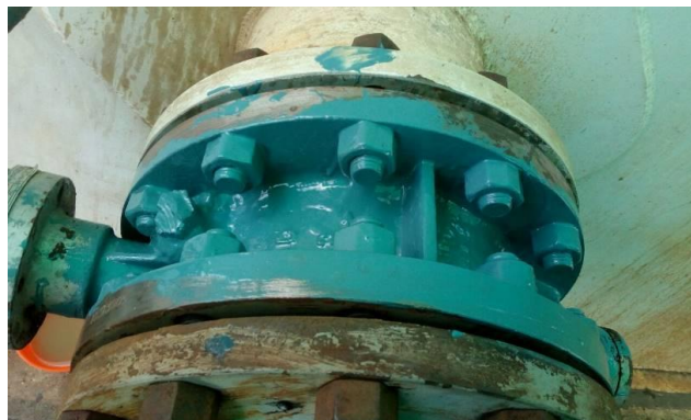
Foto No. 17 Proceso de Relleno y Reconstrucción
