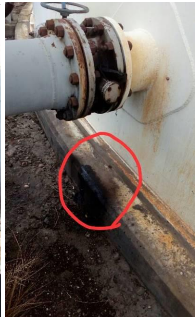
Foto No. 7 Calaján de Madera No. 2 Válvula 3415, Fuga en vivo de agua-crudo, Calaján muy inestable.
