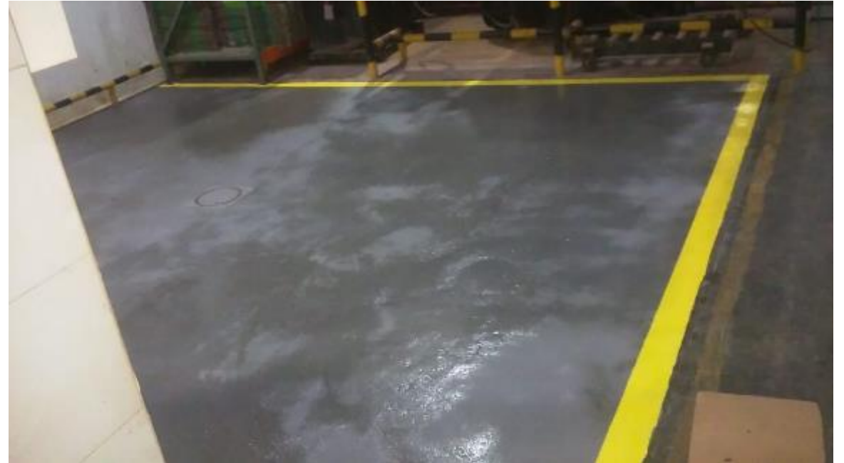
Proceso: Aplicación Producto Milamar Coatings Ref: PM500 a 2 capas para demarcación líneas amarillas
