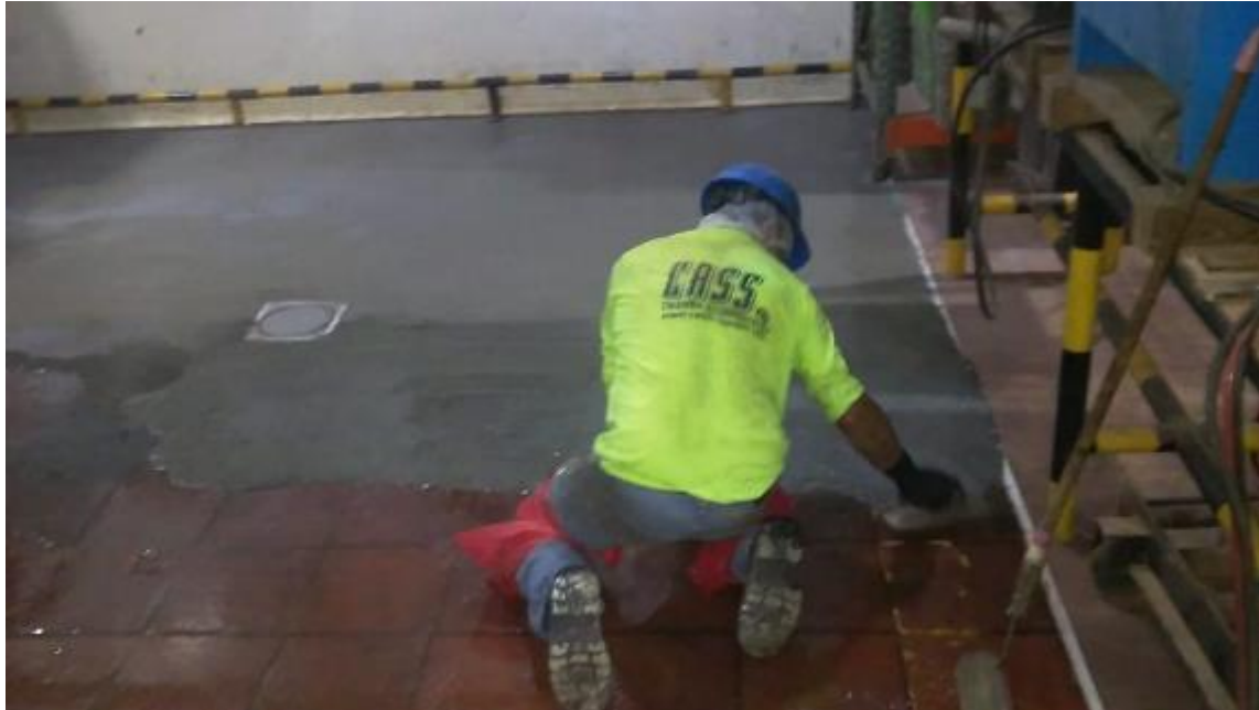
Proceso: Aplicación Producto Milamar Coatings Ref: 3800 CR a 6 mm
