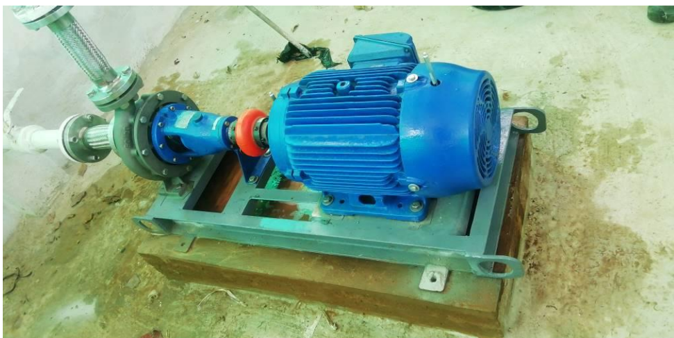
Presentación de flexibles y conjunto en base de concreto, se perforan huecos para espárragos.
