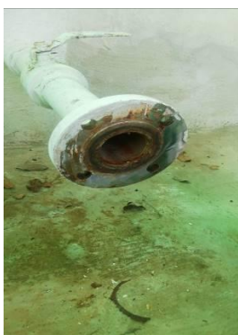
Limpieza de Brida Para conexión de succión con flexible
